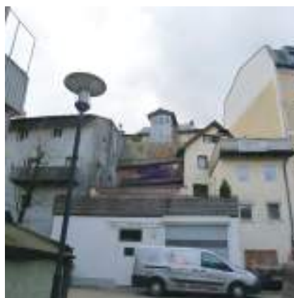
Hangkante mit Gestaltungsmängeln
